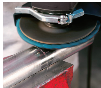
Brušenje finih zavara i uklanjanje termičkog plavog zabojenja.
